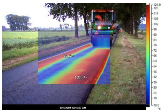
voorbeeld gebruik infraroodcamera bij project met bijzondere variatie van laagdikte
