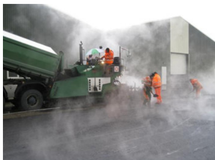
Figuur 2 – Regen + vers asfalt = waterdamp
