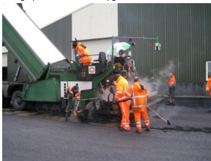
Figuur 3 – De linescanner, Wing-Yan en de asfalteerploeg werken naar behoren
