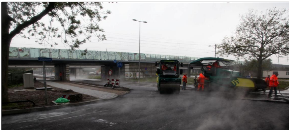
Figuur 4: Dampend asfalt door het warme asfalt en de regen gedurende de derde en laatste dag van het onderzoek.
