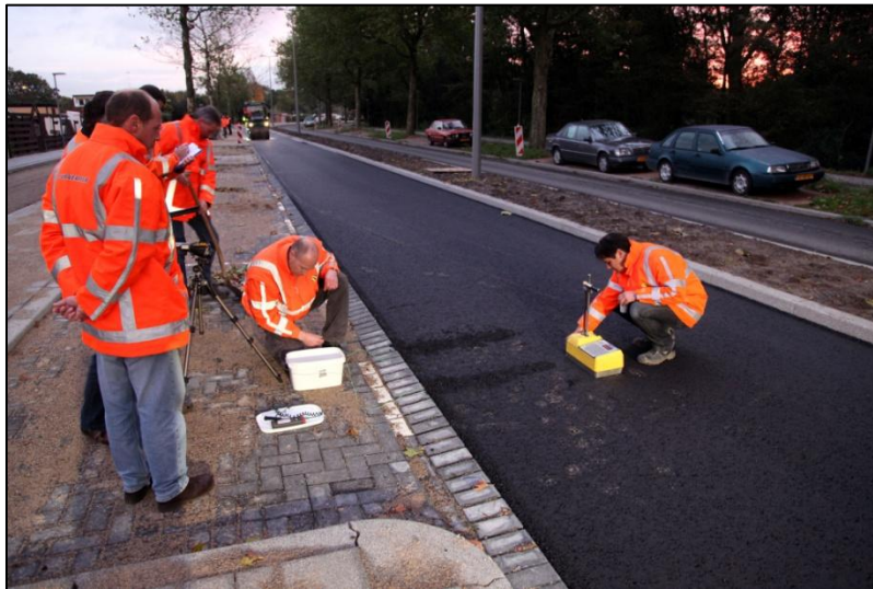
Figuur 2: Met behulp van in het asfalt ingebouwde thermokoppels wordt de interne asfalt temperatuur gemeten. Links staat de infrarood camera opgesteld. Rechts is een asfalttechnoloog van Dura Vermeer bezig de dichtheid van het asfalt te meten.
